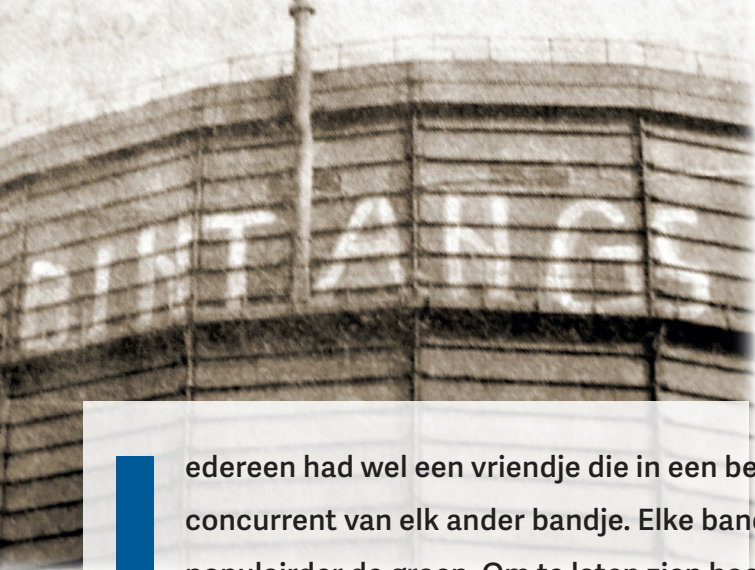
Gashouder Beverwijk met Bintangs. (Bron: onbekend, 1965)
