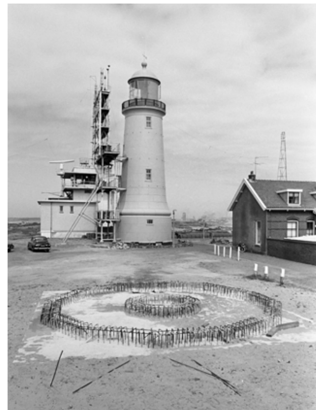
De fundering voor de buitentoren op de nieuwe locatie.
