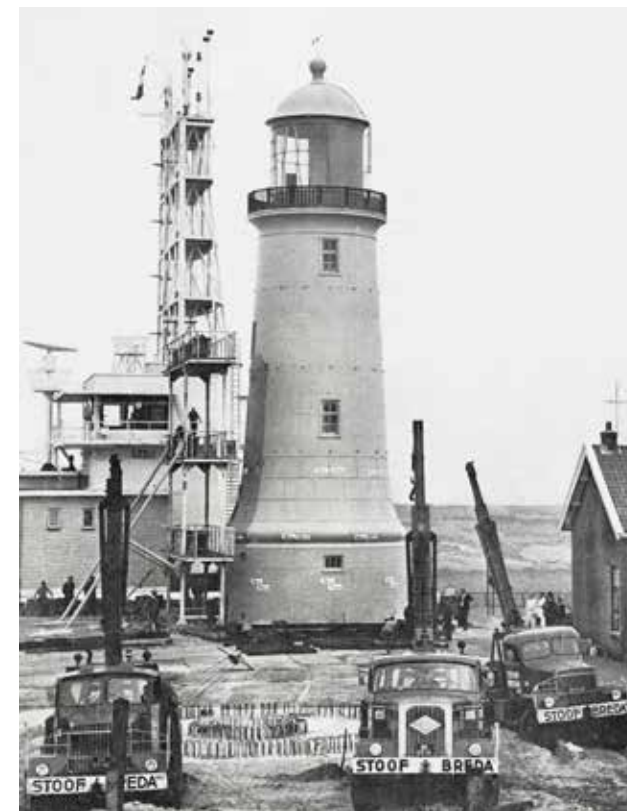
De verplaatsing van de buitentoren in volle gang.
