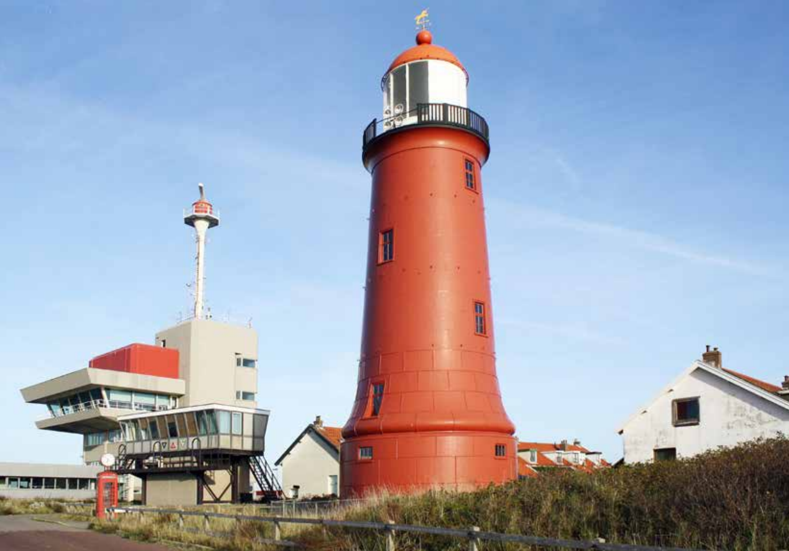
De buitentoren in 2014. Links het Haven Operatie Centrum en de voormalige seinpoststelling, nu een eenkamerhotel.
