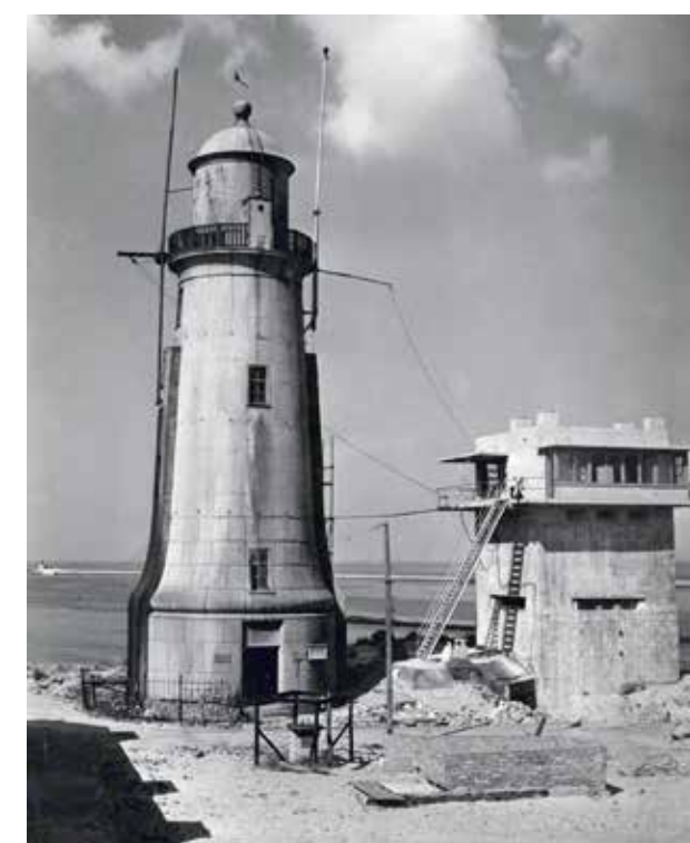
Een nieuwe semafoor in aanbouw in 1945.
